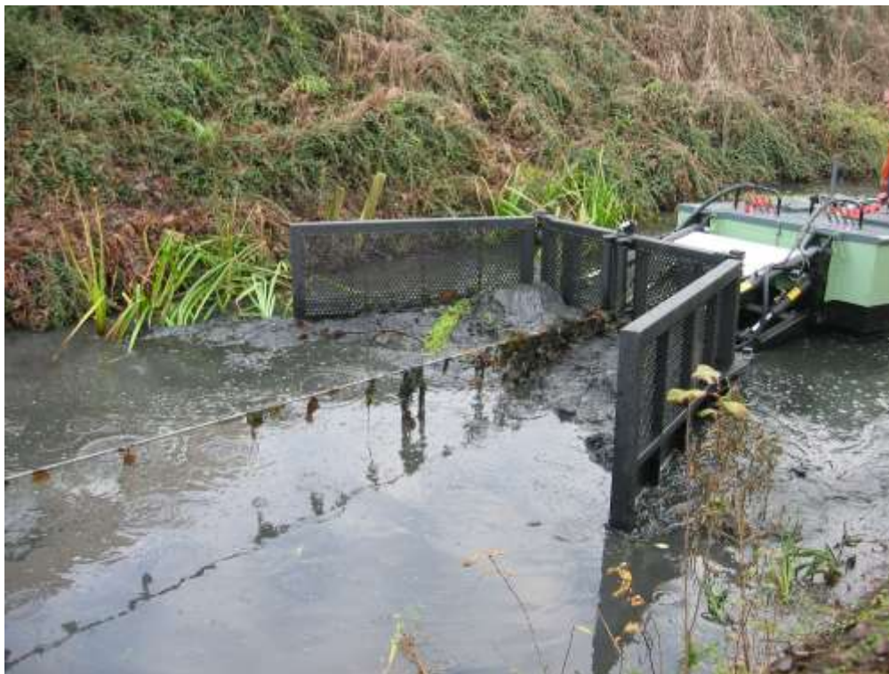
Figuur 1.2 De vijver in het stadspark is eind 2013 gebaggerd doormiddel van de 'schuifmethode'.
